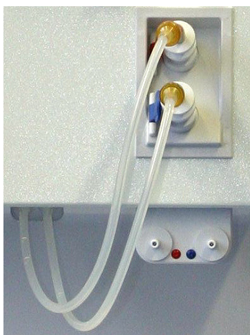
Sl. 11-27 Priključki za centralni razvod koncentratov
